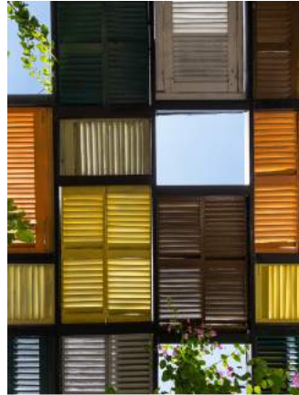
Phần mái được lợp bằng các tấm cửa cũ, một số điểm được mở để nắng, gió và ánh sáng có thể thỏa thích ủa vào ngôi nhà.
